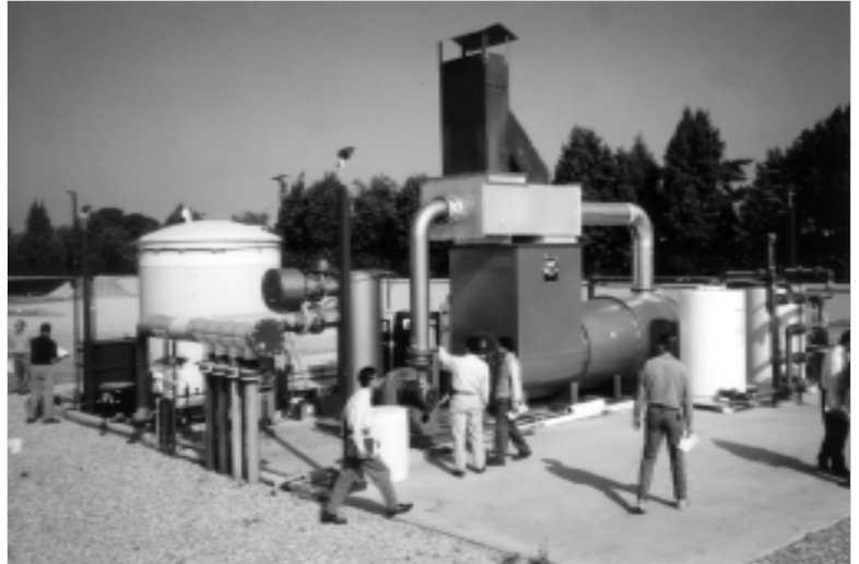
Sistema de limpieza de DESC en el área central de la Granja de Tanques es mostrado aquí durante un reciente tour del sitio. Tiene una capacidad de recuperación de 1,000 galones per mes.
