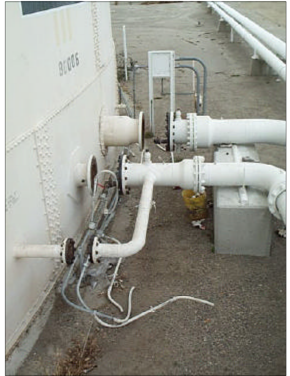
Cierre de tanques. Se han eliminado las bombas externas accionadas a motor y se ha desconectado el cableado eléctrico en cada tanque de almacenamiento de combustible.
