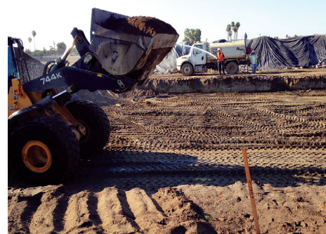
Rellenado de área excavada
