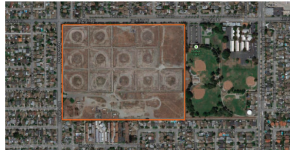
Vista aérea actualizada del Patio de Tanques del antiguo DFSP Norwalk, después de la eliminación de todos los tanques y estaciones de tanqueo.
